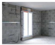
► Pièce avant la projection d'Aérobblue®
