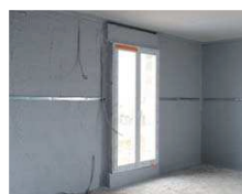
► Après la projection d'Aérobblue® et avant la pose du doublage.
